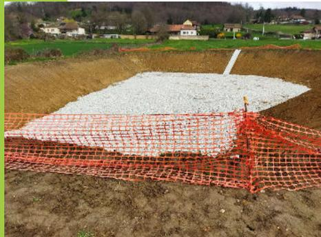
Les bassins de rétention laissent souvent interrogatifs notamment celui positionné au nord du terrain. Organe de sécurité prévu pour des crues centennales, l'évacuation des eaux pluviales s'opère du bassin Nord vers celui disposé au Sud, puis écoulement vers les bassins de rétention de la Petite Gare.
